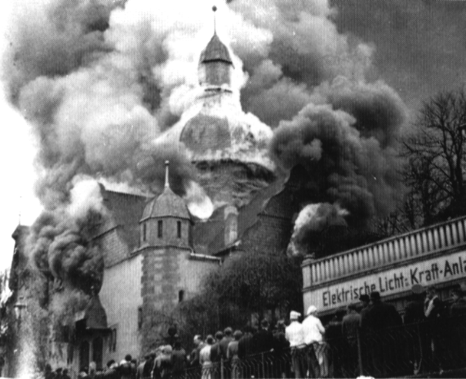
In Siegen wurde die Synagoge nicht wie anderswo am Abend des 9. November in Brand zesteckt, sondern erst am späten Vormittag des folgenden Tages (vergl. S. 32). So konnte — trotz des Photographierverbots — der Ausbruch des Feuers im Bilde festgehalten
